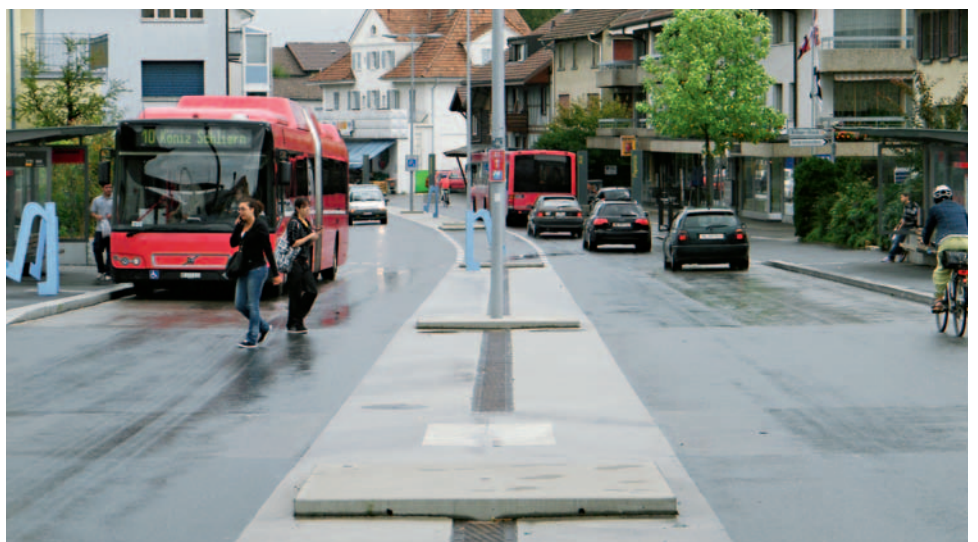
Ein gelungenes Beispiel einer Gemeinschaftsstrasse im Zentrum von Köniz (BE).
