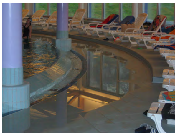
Illustration 14 Pas de pente: l'eau ne s'écoule pas
