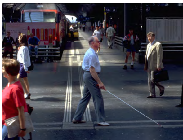
Illustration 27 Guidage tactile sur le revêtement de sol pour les aveugles
