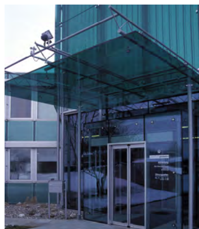
Illustration 28 Entrée avec protection contre les intempéries
